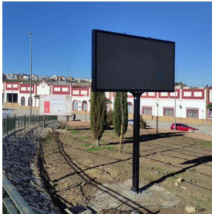
Pantalla Led sobre estructura monoposte
