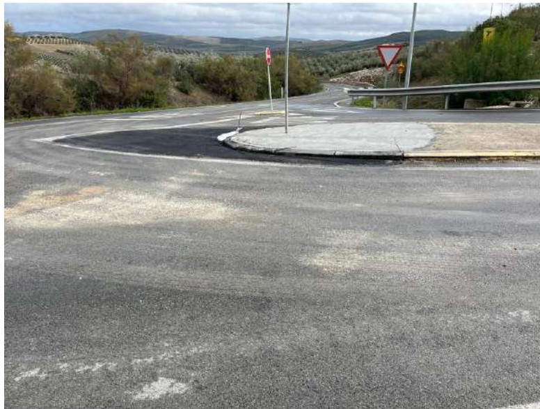
Mejora acceso de vehículos
