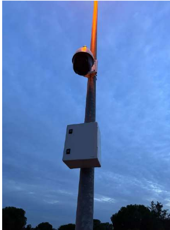
Instalación de cámaras de videovigilancia sobre báculos de luminarias existentes
