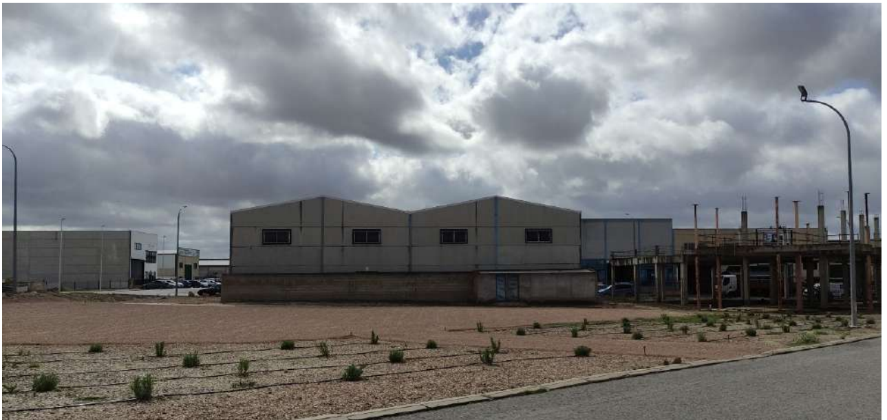
Revitalización de zona dedicada a área libre.
