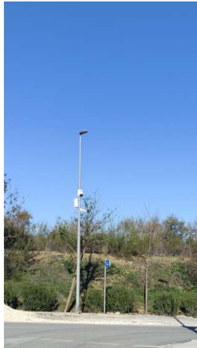
Colocación de cámaras de videovigilancia en báculos de luminarias existentes.
