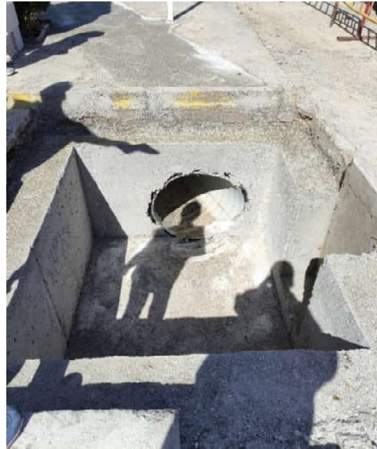
Instalación mejora de saneamiento para recogida de aguas pluviales
