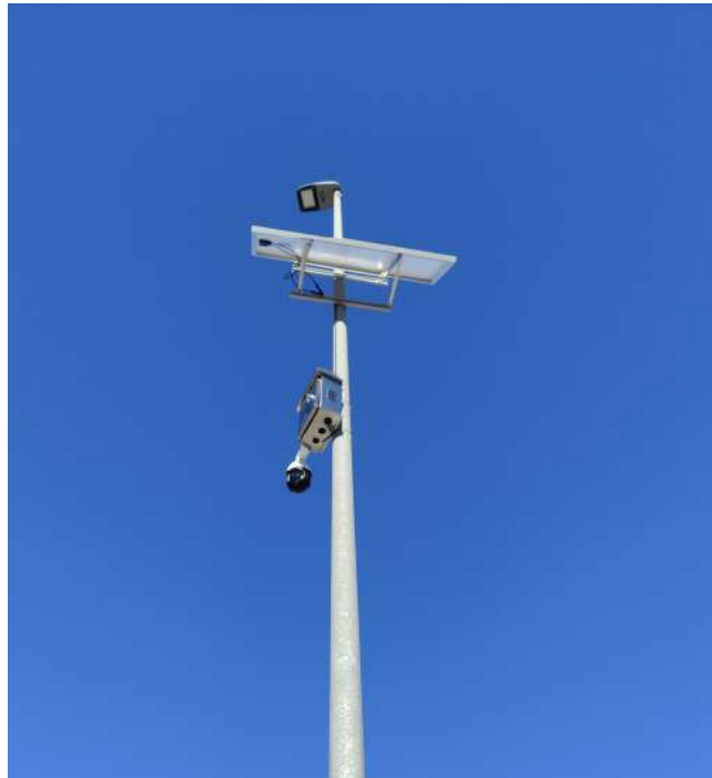
Colocación de cámaras de vigilancia sobre báculos de luminarias existentes
