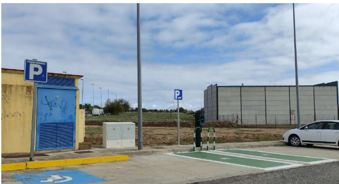
Instalación de Puntos de Recarga Eléctrica
