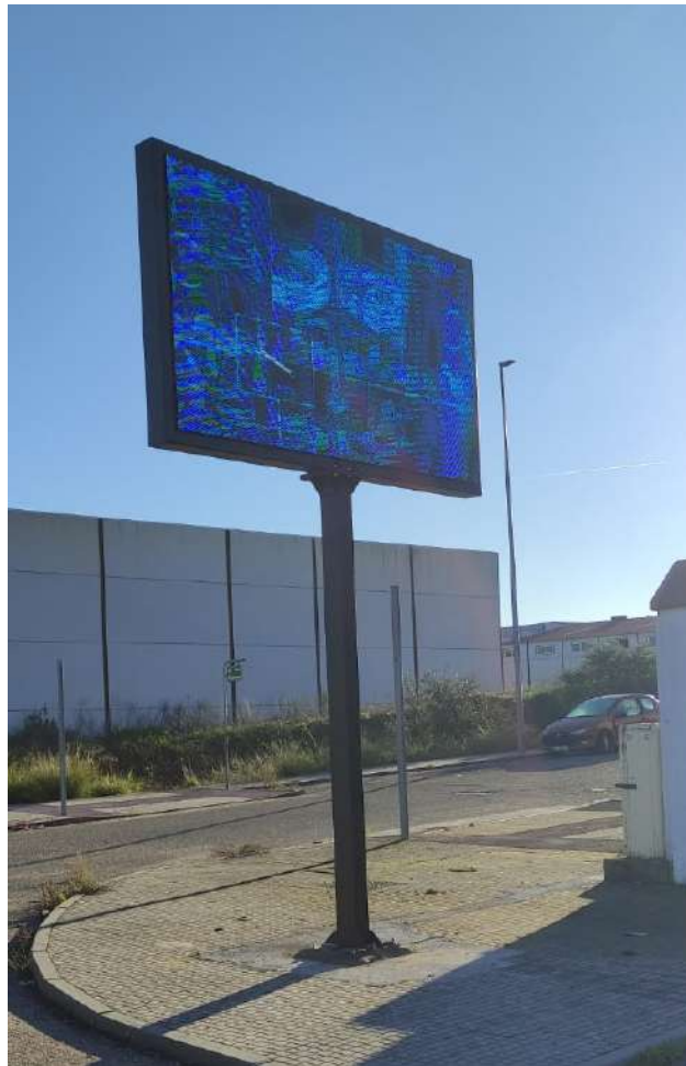
Colocación de pantalla Led
