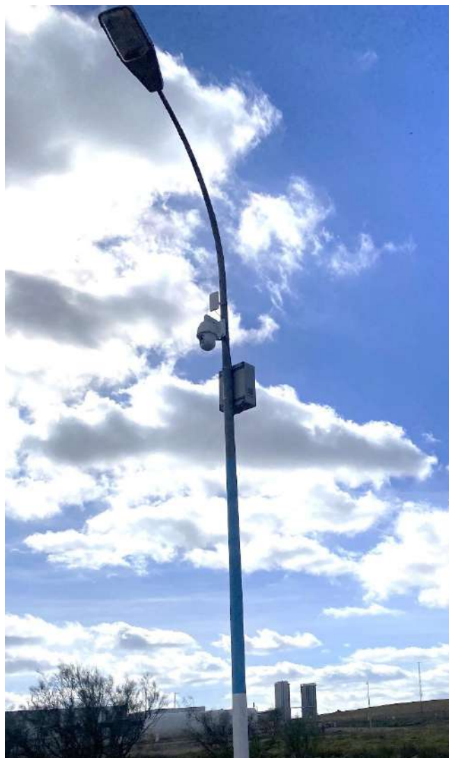
Instalación de cámara de videovigilancia en báculo de luminaria.
