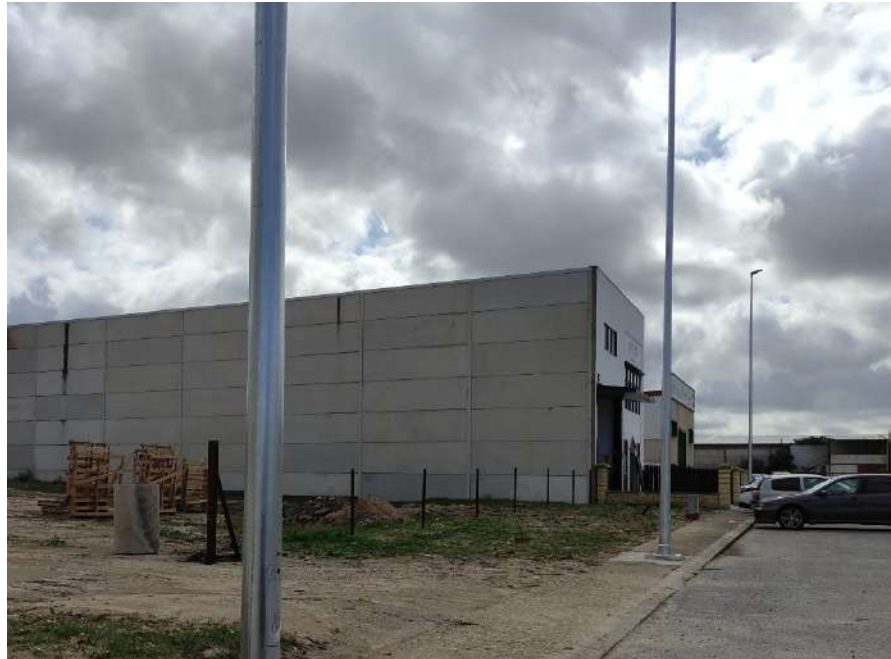
Colocación de nuevas luminarias
