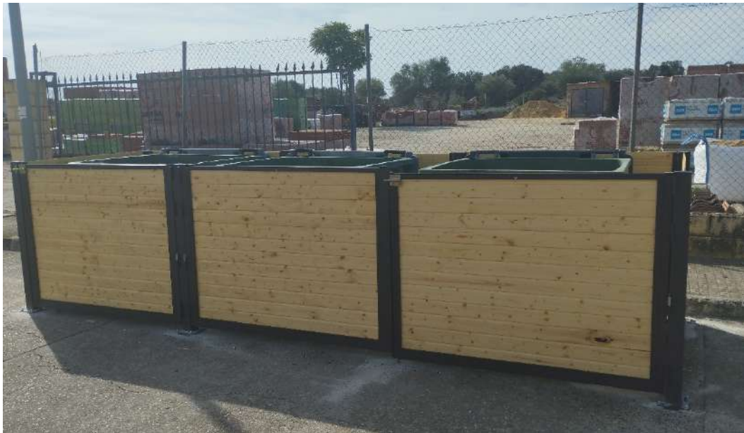
Instalación de cubrecontenedores
