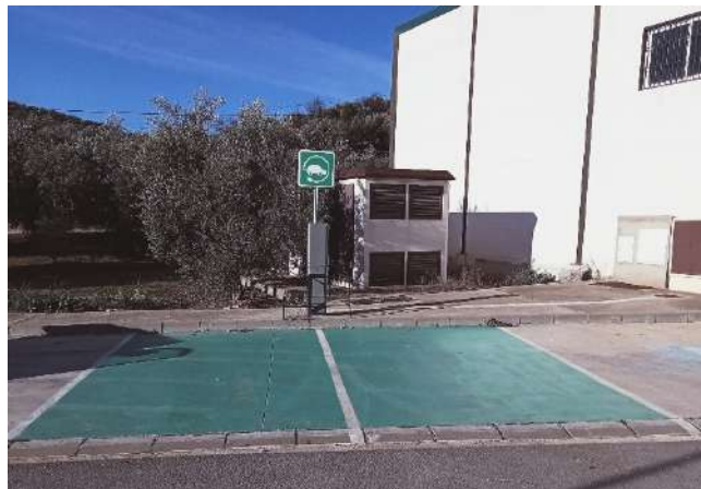
Instalación de punto de recarga coches eléctricos
