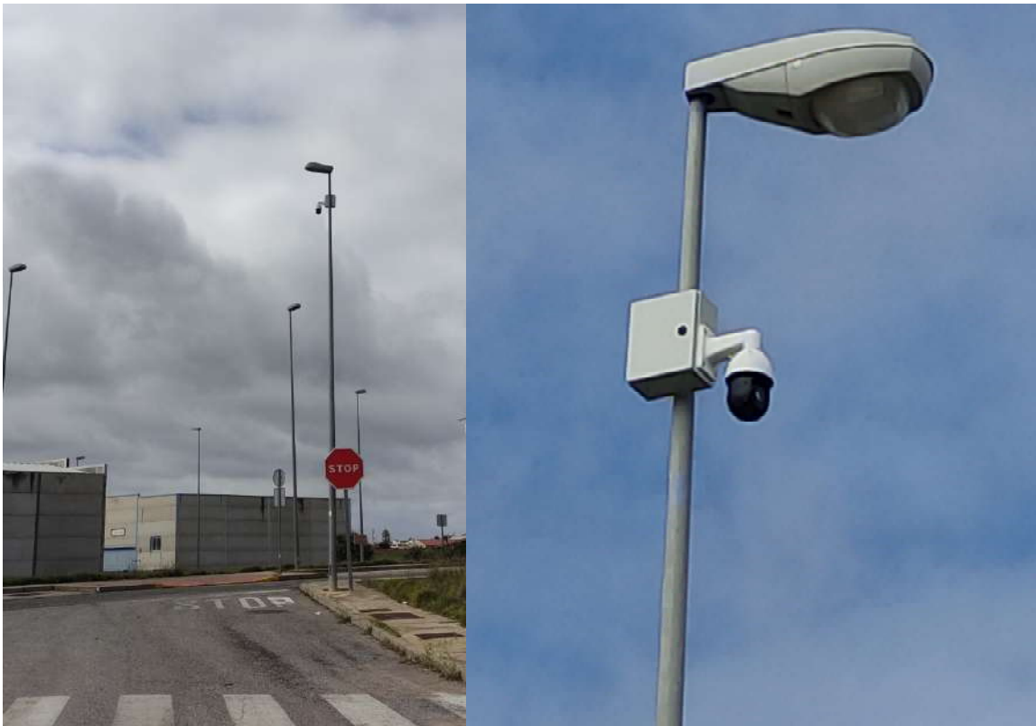
Colocación de cámaras de videovigilancia sobre báculos de luminarias existentes
