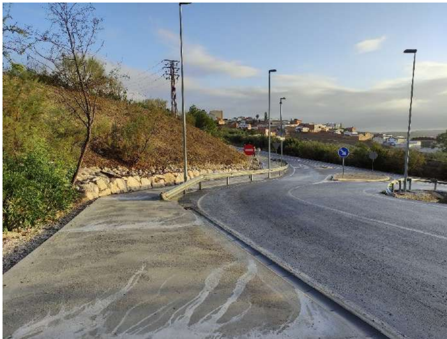
Ejecución de Acceso Peonal.
