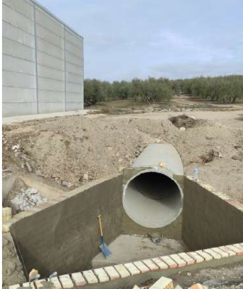
Ejecución de recogidas de aguas pluviales
