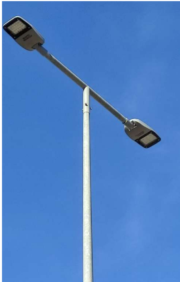
Sustitución de luminarias sobre báculos existentes
