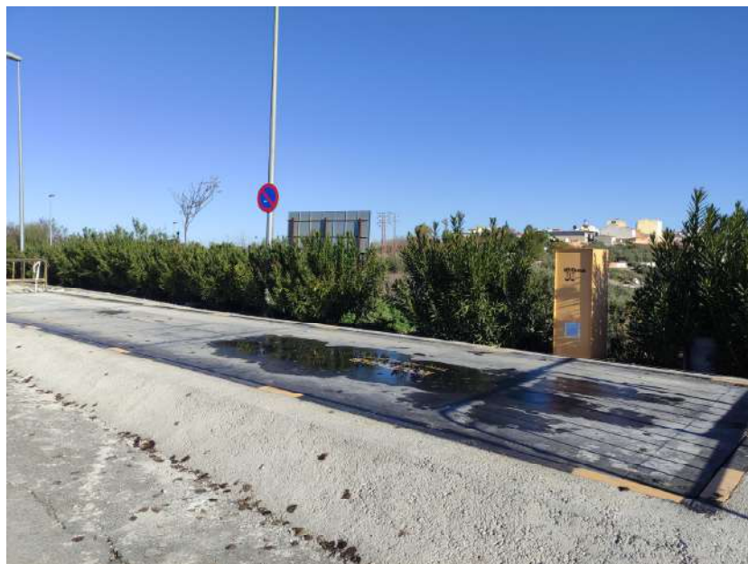
Ejecución de Báscula para camiones.
