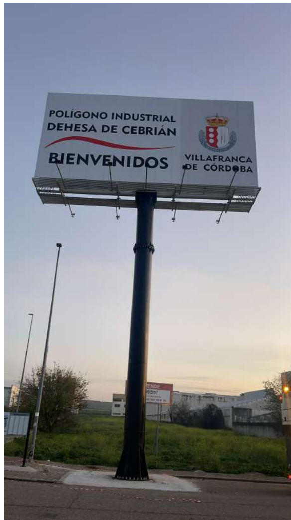
Colocación de Monoposte gran tamaño
