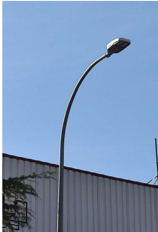
Imagen de luminaria una vez sustituida.
