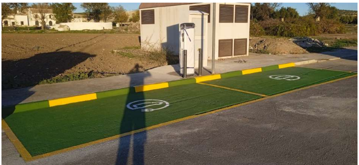
Instalación de poste con puntos de recarga
