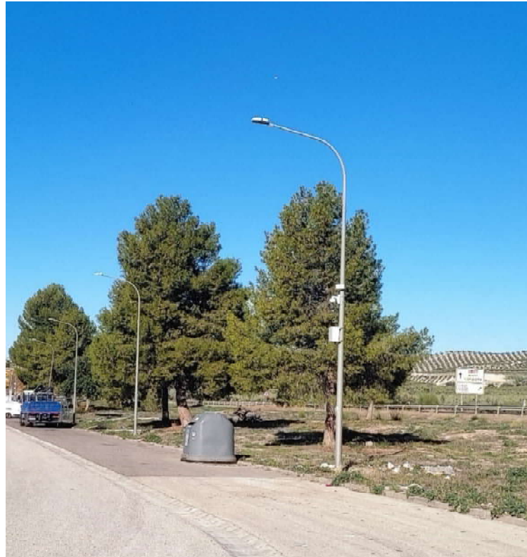
Colocación de luminarias tipo Led sobre báculos existentes
