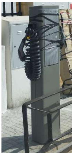
Instalación de puntos de recarga eléctrica
