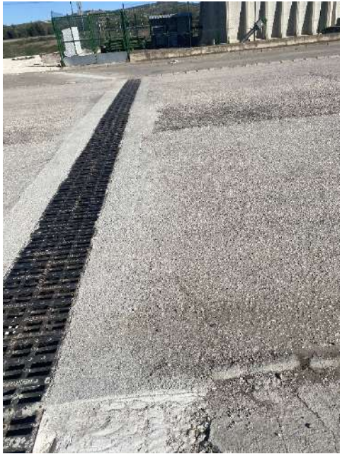
Instalación mejora de saneamiento para recogida de aguas pluviales
