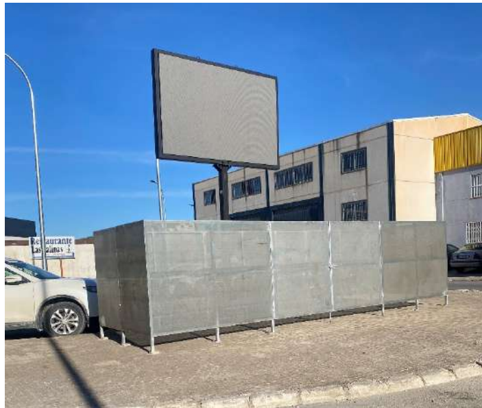
Colocación de cubre-contenedor
