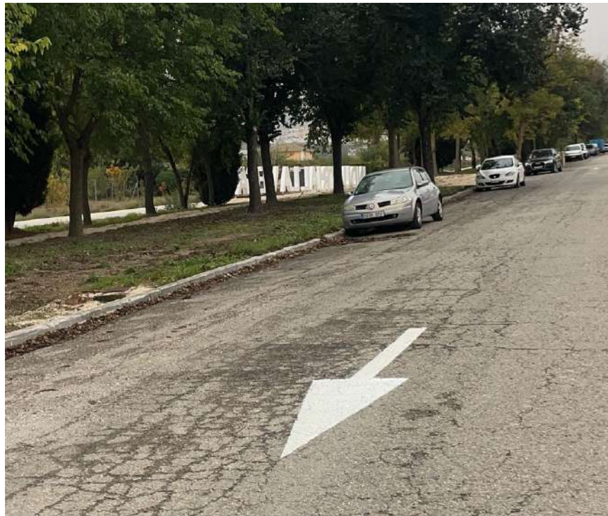
Señalización horizontal en calzada
