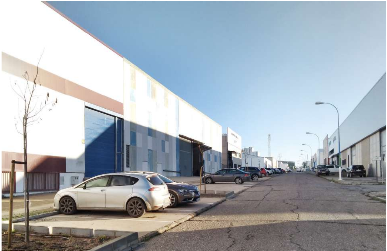
Creación de parterres para árboles y delimitación de plazas de aparcamientos
