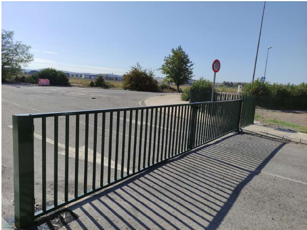
Cerramiento ejecutado en 2ª Fase
