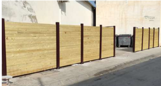
Instalación de cubre contenedores.
