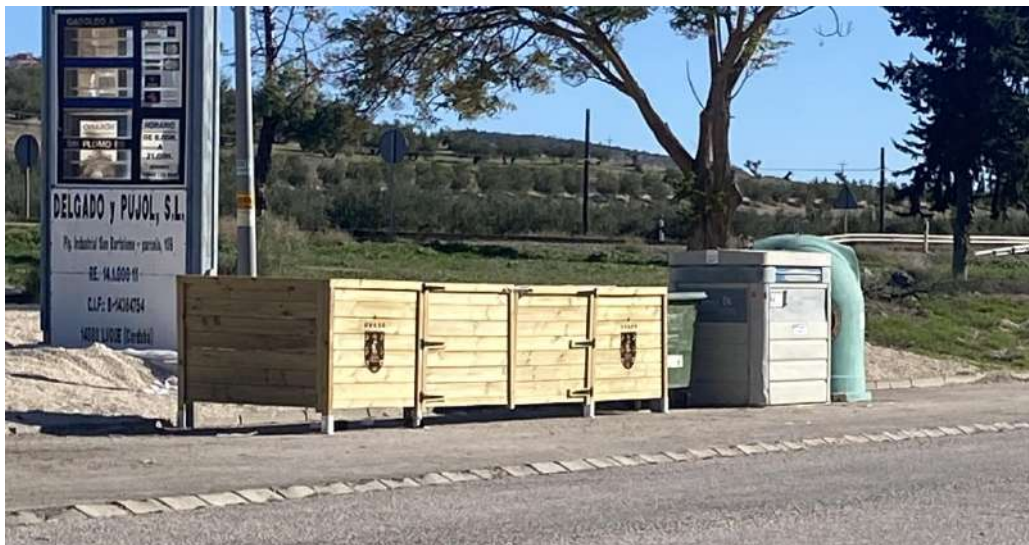
Colocación de cubrecontenedores
