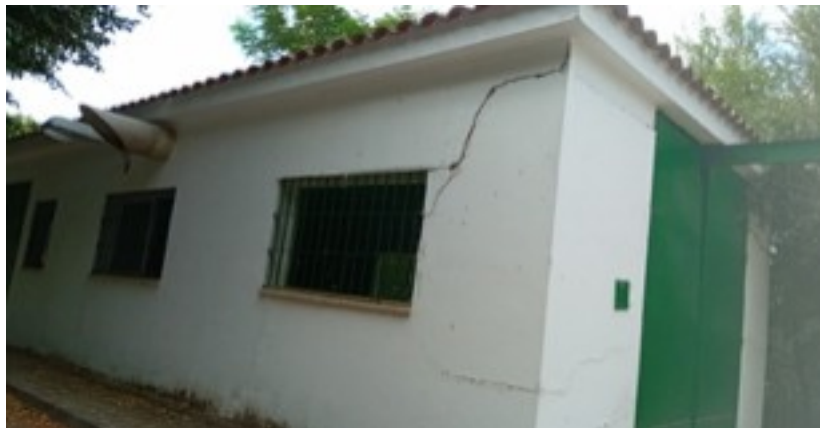
EBAR N° 1 VILLA DEL RÍO
