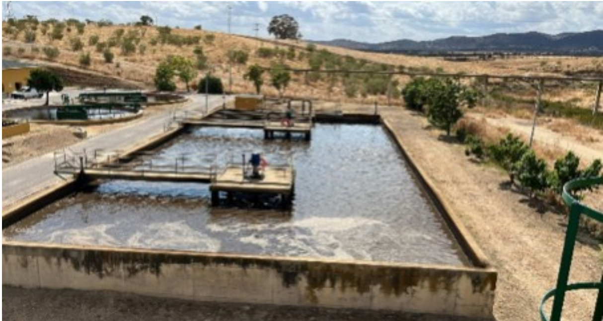
EDAR PEÑARROYA - PUEBLONUEVO
