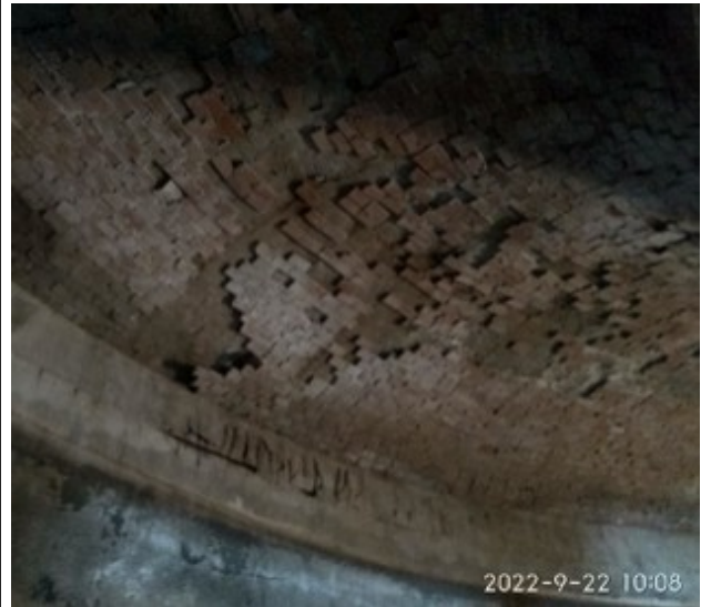
DEPÓSITO DE VILLANUEVA DE CÓRDOBA
